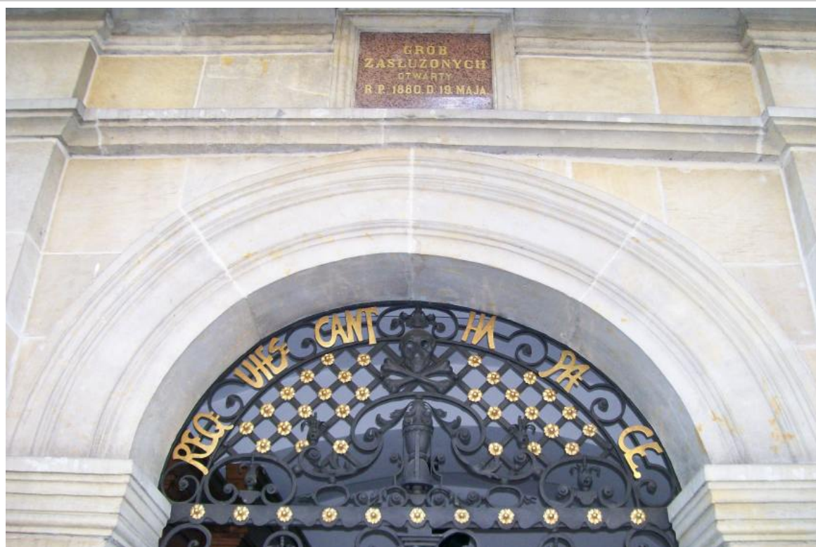
Portal Grobu Zasłużonych. Fot. L. Kordylewski
